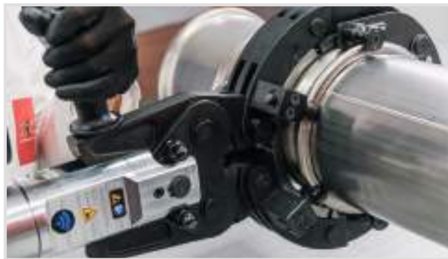
Assemblaggio pressatura n°2 / Press assembly phase 2
